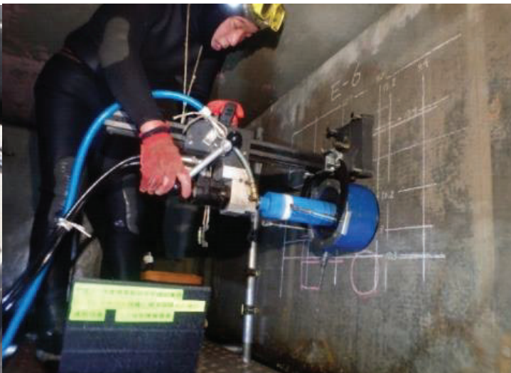
暗所による施設点検状況
