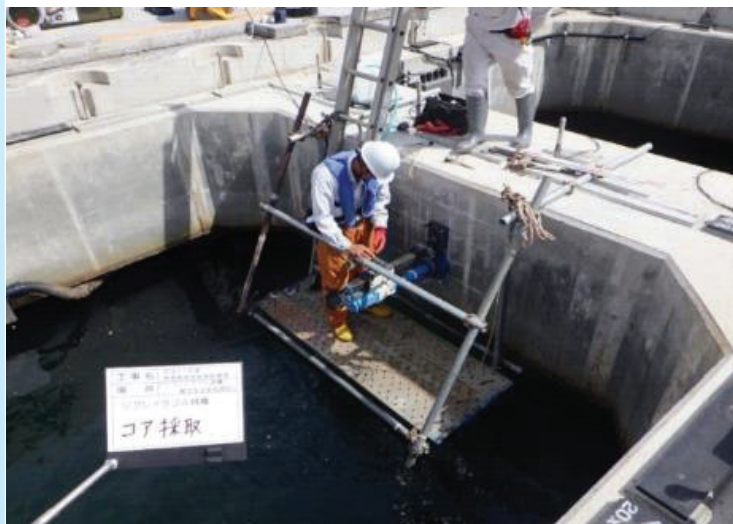
上床版撤去による施設点検状況
