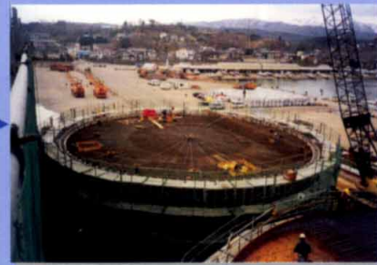
②サクシヨン基礎製作状況(RC製) (平成11年3月)
