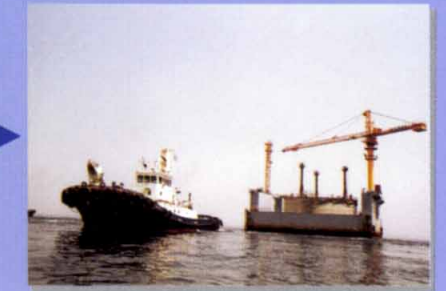
⑥サクシヨン基礎の曳航 (平成11年6月)
