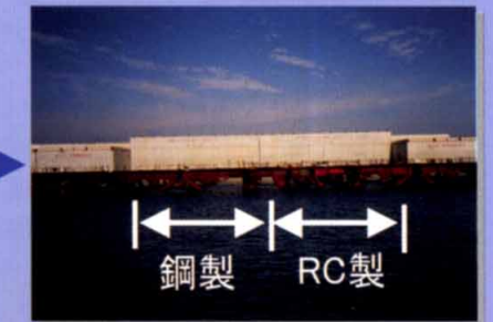
⑫実証試験堤の完成 (平成11年8月)
