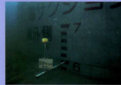
⑩サクシヨン基礎沈設完了後の 貫入状況
