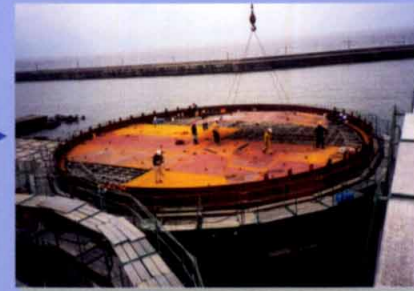
③サクシヨン基礎製作状況(鋼製) (平成11年3月)
