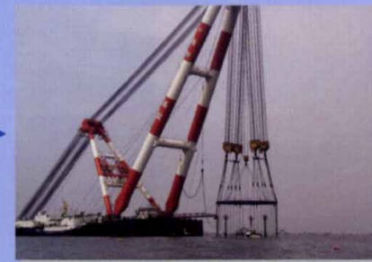
⑨サクシヨン基礎据付状況(RC製)
