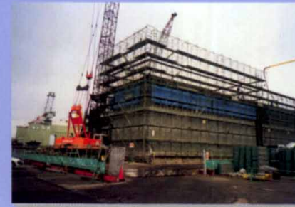
④上部ケーソン製作状況 (平成11年3月)
