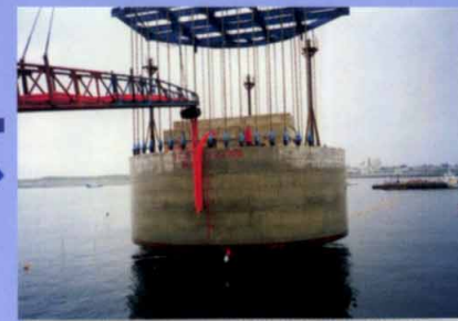
⑦サクシヨン基礎据付直前(RC製) (平成11年6月)
