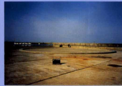
①サクシヨン基礎架台 (平成10年12月)
