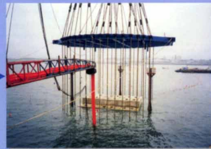
⑧サクシヨン基礎据付開始(RC製)
