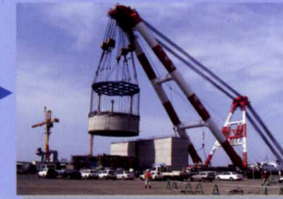
⑤サクシヨン基礎の積み込み(RC製) (平成11年5月)
