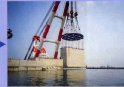
⑪上部ケーソン据付 (平成11年7月)
