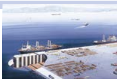
軟弱な地盤に対応した根入式鋼板セルによる大型岸壁（七尾港）
