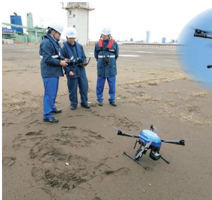
能登半島地震発生直後の被災状況調査
