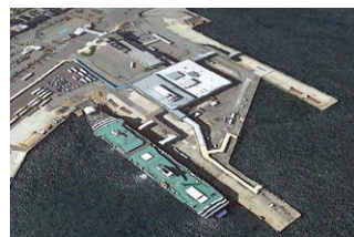
両津港(港地区)岸壁(-7.5m)(耐震)
