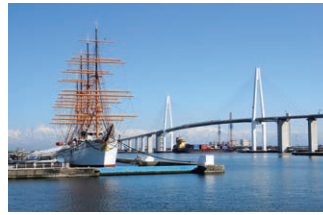
伏木富山港新湊大橋
