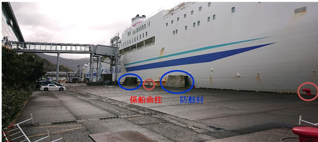
図 2-2 係留施設上の附帯設備の例
