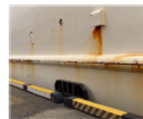
船体防舷材等の突起物
