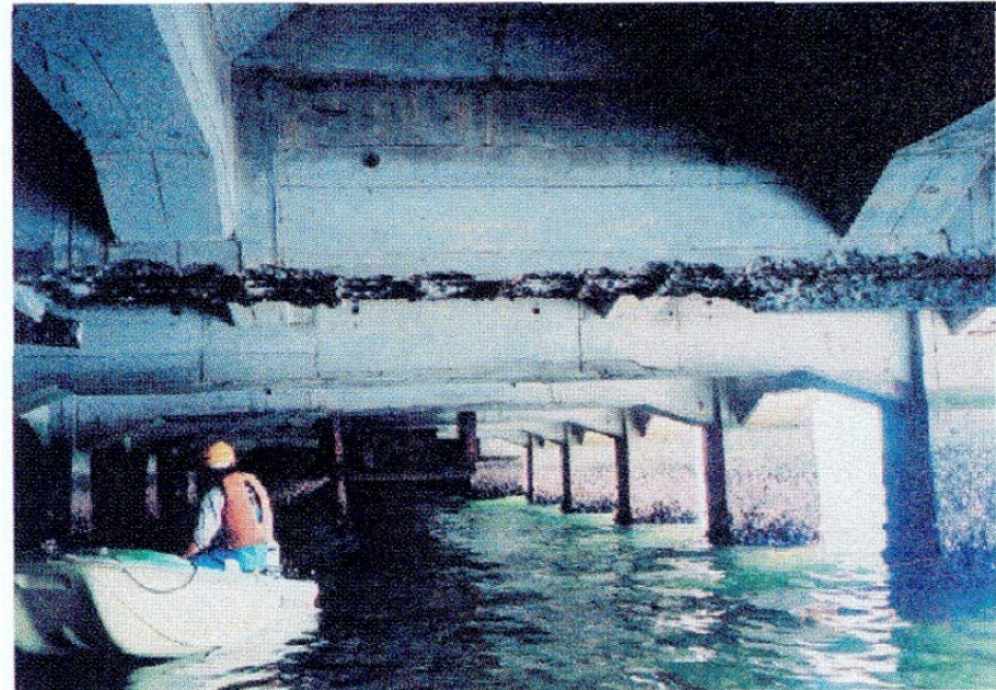
栈橋上部工の点検状況
