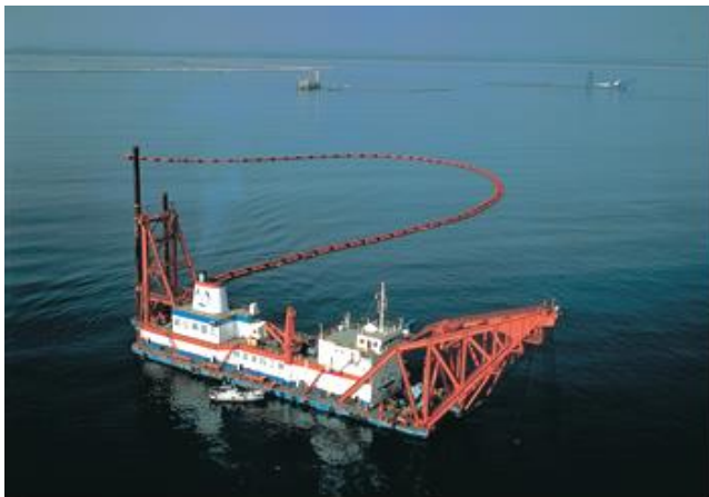
ポンプ浚渫（作業船協会HPより）
