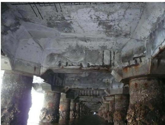
栈橋RC上部工の劣化事例
