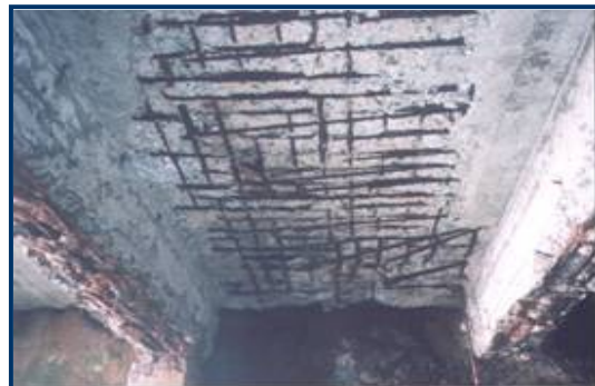
鉄筋の腐食によるコンクリートの剥離
