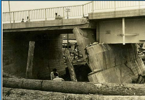
八千代橋の橋脚
