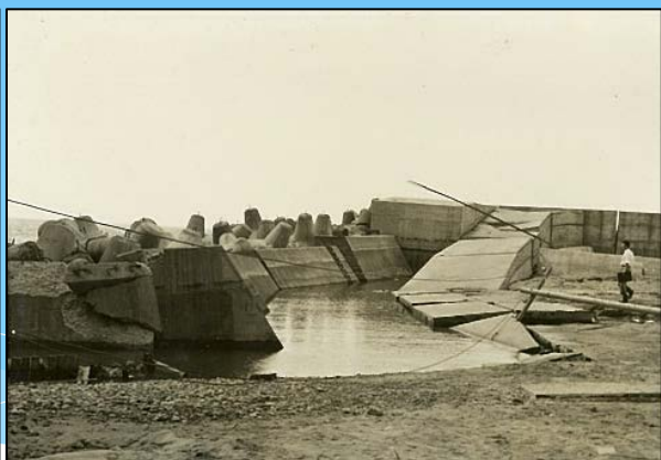
西突堤元付部
