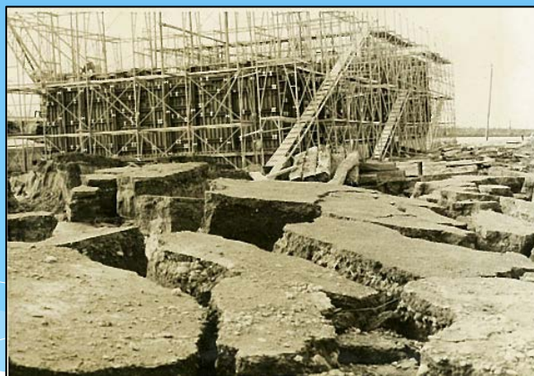
ケーソンヤード(事務所)
