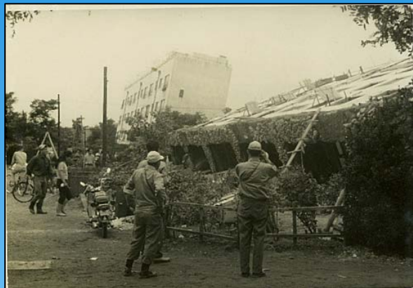
川岸町県営アパート
