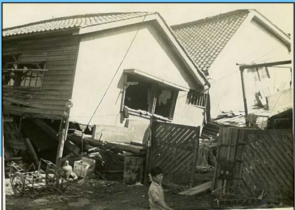
建築物の被害(船場町)
