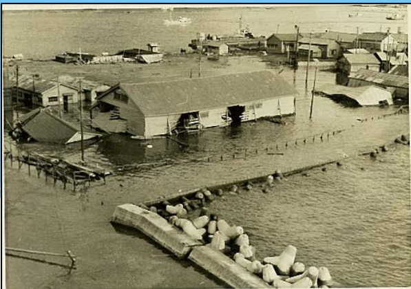
浸水状況(事務所)
