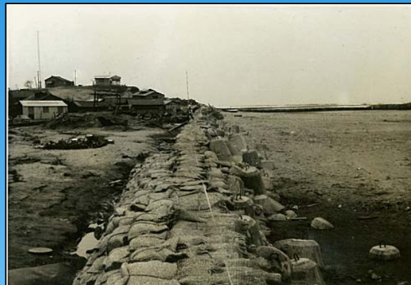
西海岸(応急工事)
