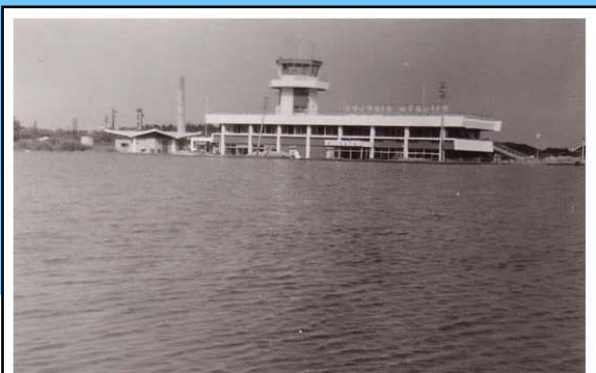
新潟空港冠水状況
