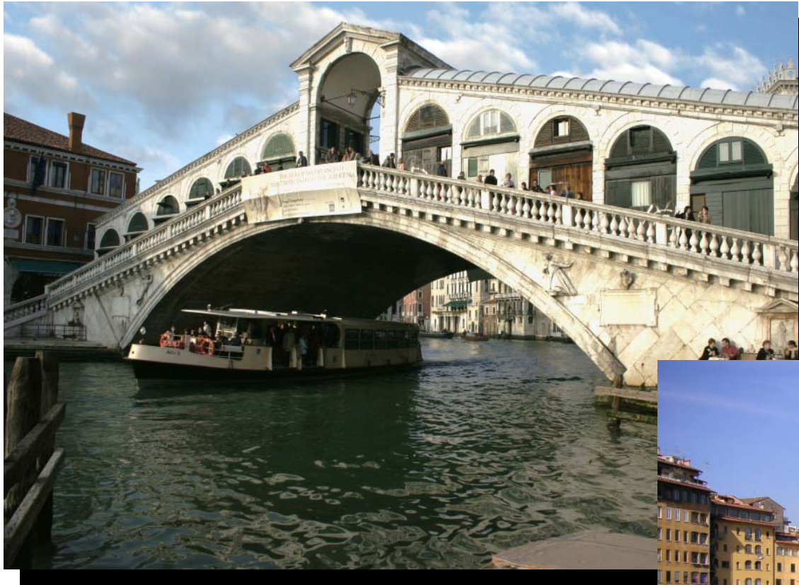
リアルト橋(ベネチア) 1591年
