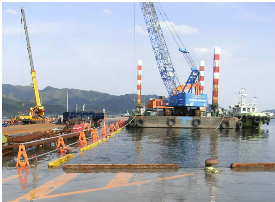
満潮時に防舷材が完全に水没
