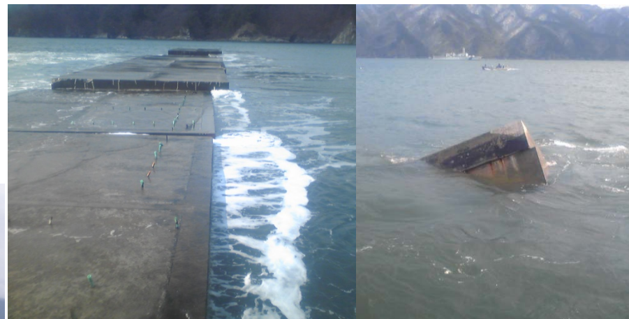
【竜神崎地区防波堤： 左)海側から陸側へ展望(法線出入り) 右)海側先端部 倒壊状況】
