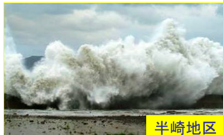
台風12号による 越波状況(H18.9)
