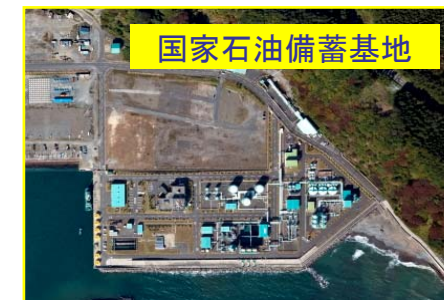
備蓄量175万キロリットル(地下タンク式)
