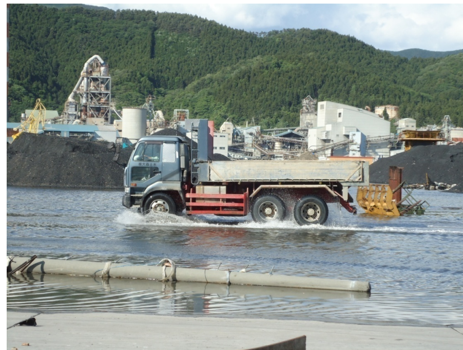
浸水のため石炭の野積み及び車両の通行に支障
