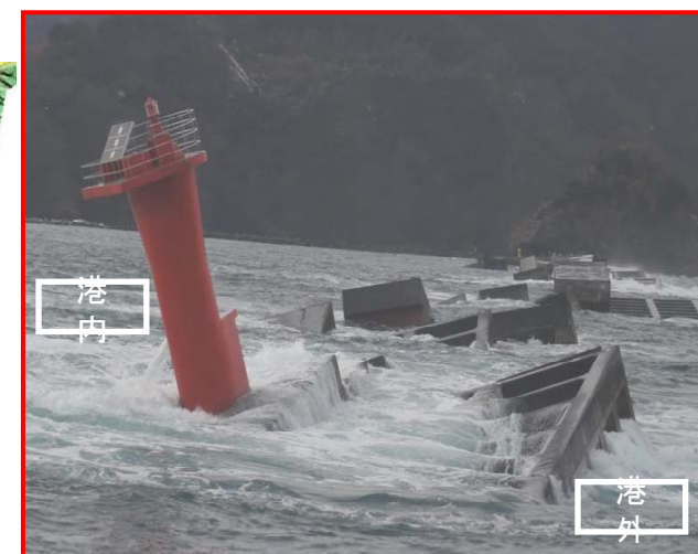
(撮影) 北堤の倒壊状況
