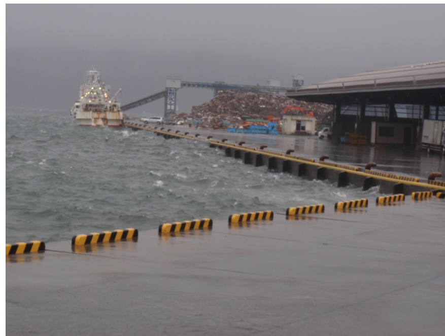
-9m岸壁【平成23年5月30日撮影】
