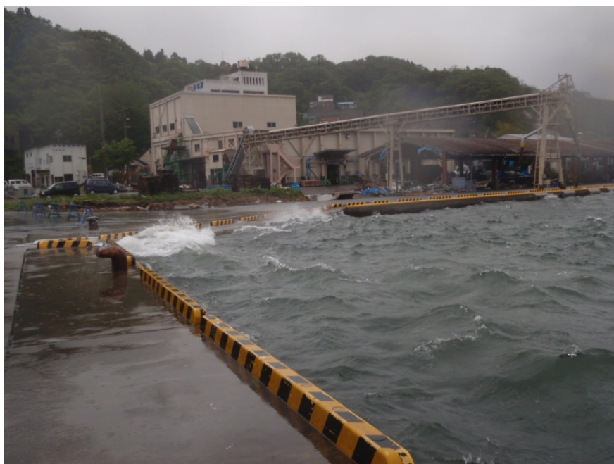
-5m岸壁【平成23年5月30日撮影】
