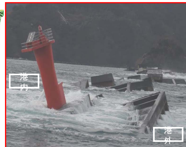
(撮影) 北堤の倒壊状況
