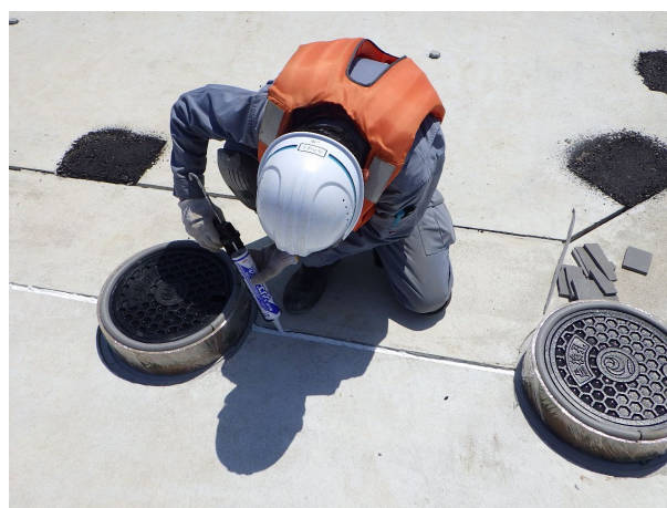
写真 4.12 シーリング材(2成分型)充填状況 (伏木富山港における施工例)
