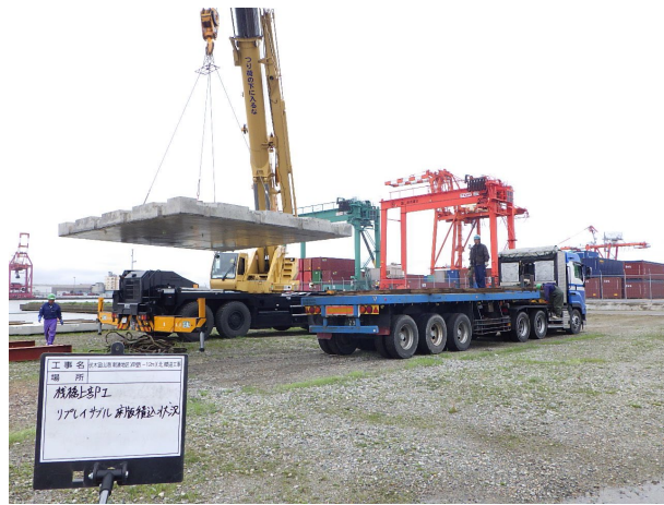
写真 4.5 床版積込み状況（伏木富山港における施工例）
