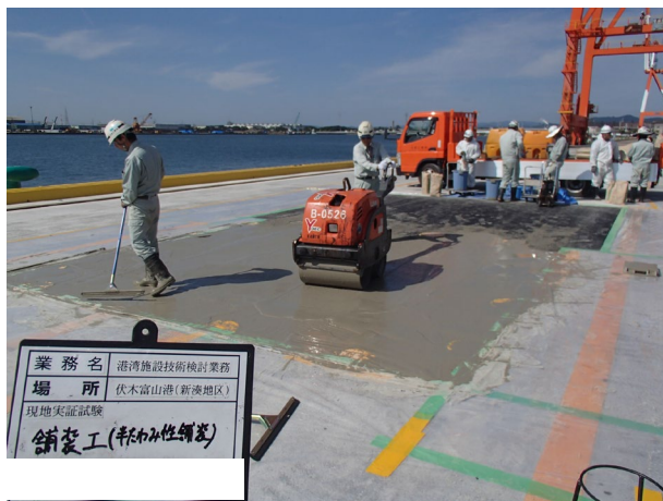
写真 4.17 半たわみ性舗装敷設状況（伏木富山港における施工例）
