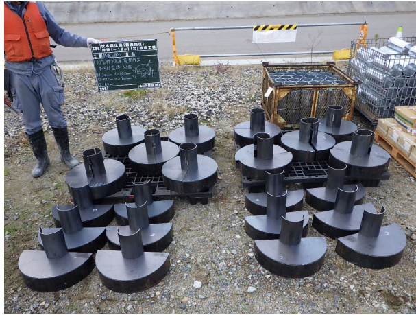
写真 4.2 箱抜き型枠の製作（伏木富山港における施工例）
