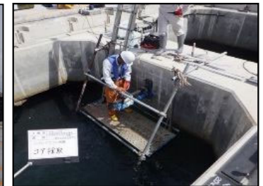
栈橋詳細（模擬）点検状況
