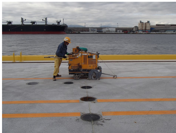
写真 4.18 舗装敷設準備状況（伏木富山港における施工例）
