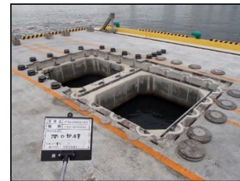
施工性確認試験実施状況（左：床版撤去、右：床版再設置（据付））
