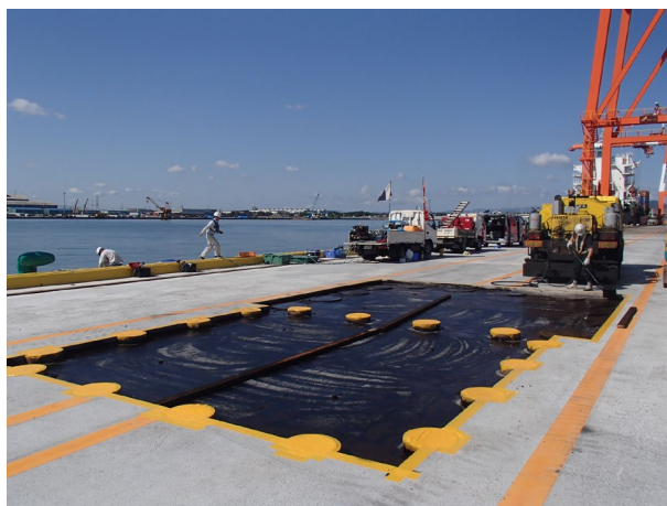
写真 4.13 舗装敷設前状況（伏木富山港における施工例）
