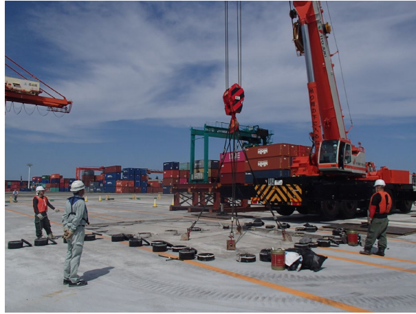
写真 4.21 床版取外し状況（伏木富山港における施工例）
