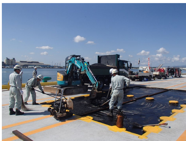
写真 4.14 基層(人力)施工状況（伏木富山港における施工例）
