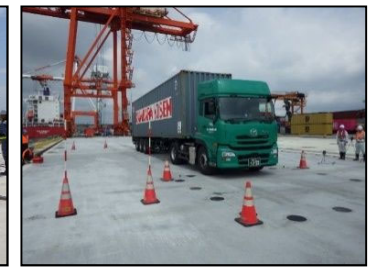
動的載荷試験実施状況
