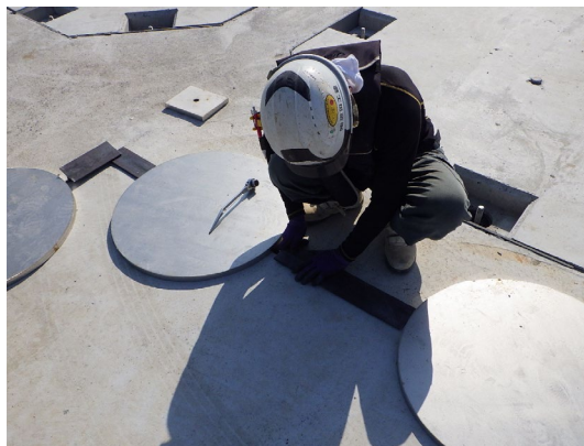
写真 4.11 鋼製仮蓋設置状況（伏木富山港における施工例）
