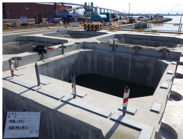
写真 4.4 沓座設置状況（伏木富山港における施工例）
