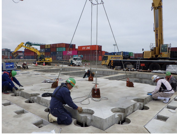
写真 4.6 床版据付状況（伏木富山港における施工例）
