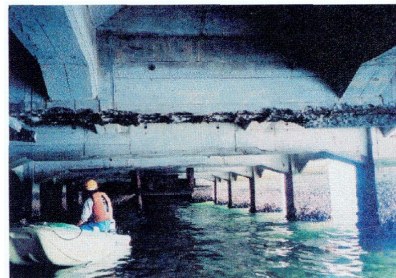
栈橋上部工の点検状況
