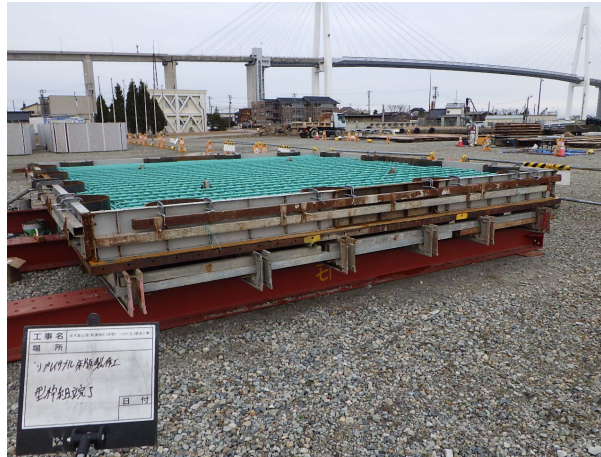
写真 4.1 鋼製型枠の使用状況（伏木富山港における施工例）
