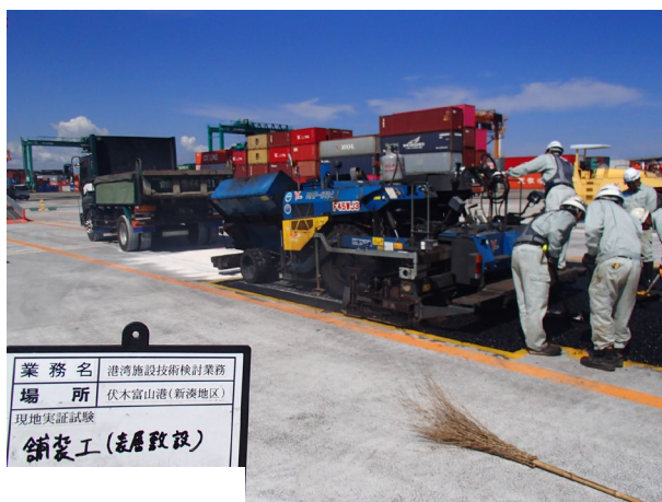
写真 4.15 表層(機械)施工状況（伏木富山港における施工例）
