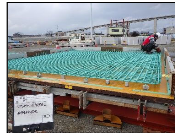
リプレイサブル床版製作状況
