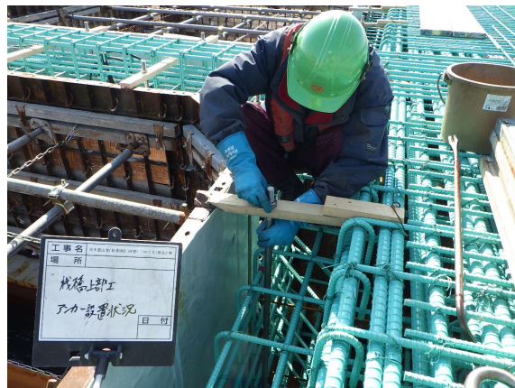
写真 4.3 アンカー設置状況（伏木富山港における施工例）
