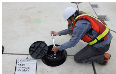
写真 4.8 アンカーボルト締結状況（伏木富山港における施工例）
