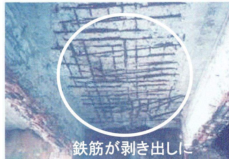
栈橋上部工の劣化事例
