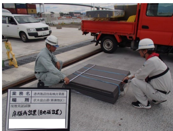
写真 4.9 ポリエチレン発泡目地材（伏木富山港における施工例）
