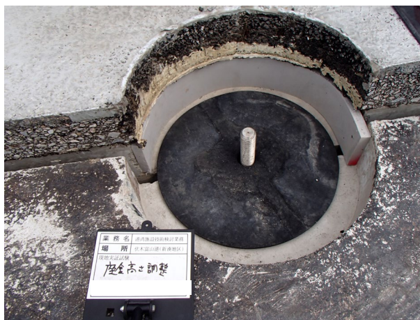
写真 4.7 ゴム質系目地板による高さ調整（伏木富山港における施工例）
