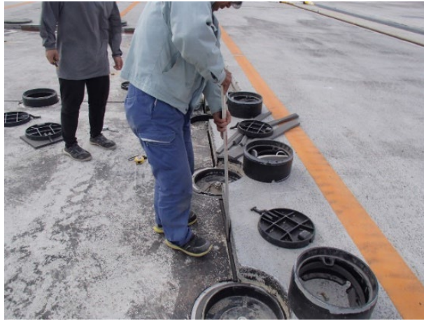
写真 4.10 目地板設置状況（伏木富山港における施工例）
