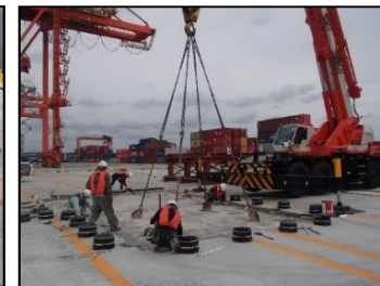
施工性確認試験実施状況（左：床版撤去、右：床版再設置（据付））
