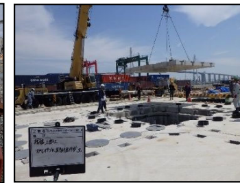
床版の設置状況
